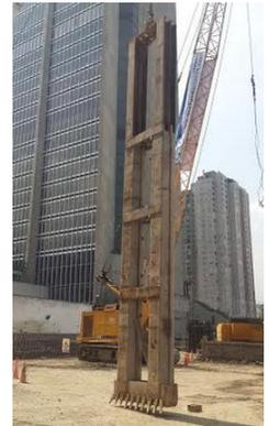
Durante la rettifica dello scavo si può fin quando l'utensile lavora fuori dalla guida sollevare o abbassare il braccio della gru in modo che forzi il taglio in maniera più incisiva. All'occorrenza quando il modulo raggiunge profondità elevate si può aggiungere un elemento in testa al primo in modo tale da allungare l'attrezzo. Diciamo che più e' lungo maggiore sarà l'appoggio che otterremo nella parete di scavo e migliore ne risulterà l'utilizzo.
