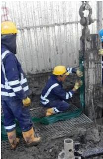
Inseriamo il profilato facendo attenzione che si abbassi nella posizione corretta e senza spostarsi sia verticalmente che lateralmente mantenendosi al segno, e man mano che caliamo gli montiamo il "water stop" assicurandola bene nella guida.
