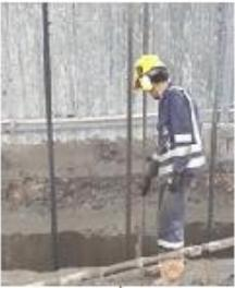
Un'altro controllo che possiamo fare semplicemente e quello che riguarda la deviazione dell'asse **X** e lo eseguiamo semplicemente avvicinando una tavola alle funi della benna e lasciando scendere l'utensile nella guida fino quasi al fondo, controllando che non si sposti lateralmente.
