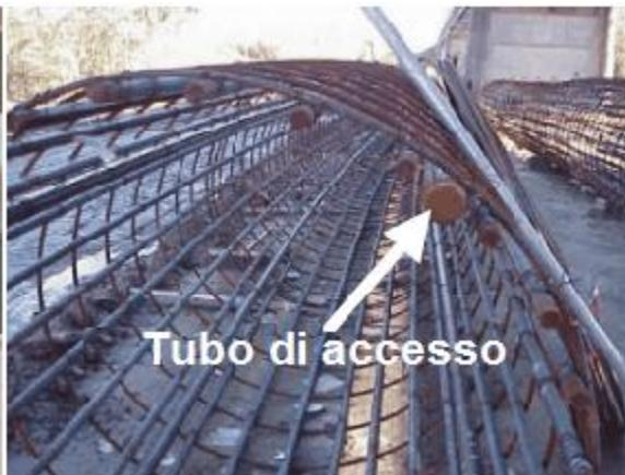
Qui a sinistra è illustrato un tubo di accesso all'interno dell'armatura. Notare il tappo sul tubo-questo impedisce detriti o calcestruzzo di entrare nel tubo e rendere inutile il test.
