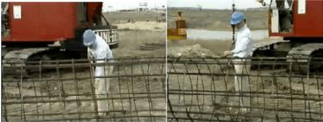
L'ispettore verifica il diametro gabbia misurando con un nastro e sta controllando che le legature siano in conformità al progetto. Solitamente, dai disegni di fabbricazione sono specificate e determinate le percentuali delle intersezioni e delle legature.
