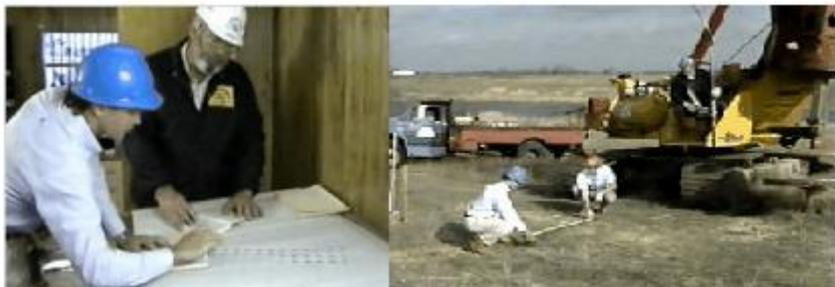
Questa fotografia mostra l'ispettore e il contraente durante il controllo e la verifica, sui disegni di progetto, e in cantiere per determinare la posizione esatta dei pali.
